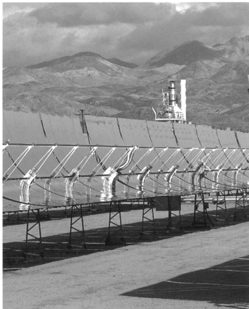
圖3.15 太陽光的熱用途，凹面鏡將太陽光聚於中心部位的液體內，加熱該液體，再傳至水，使水變成水蒸氣發電。(資料來源：高立圖書，環境科學概論，第393頁，圖7.9)
